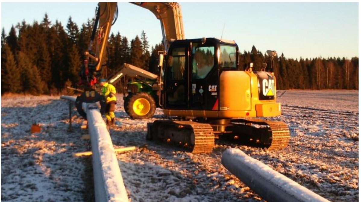
Legging av vannledning ved Rustad des. 2014
